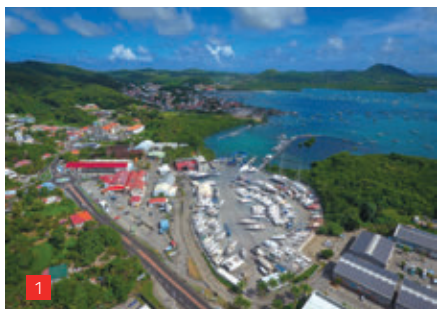
1 CENTRE DE CARÉNAGE DU MARIN LIVRÉ EN 2015
