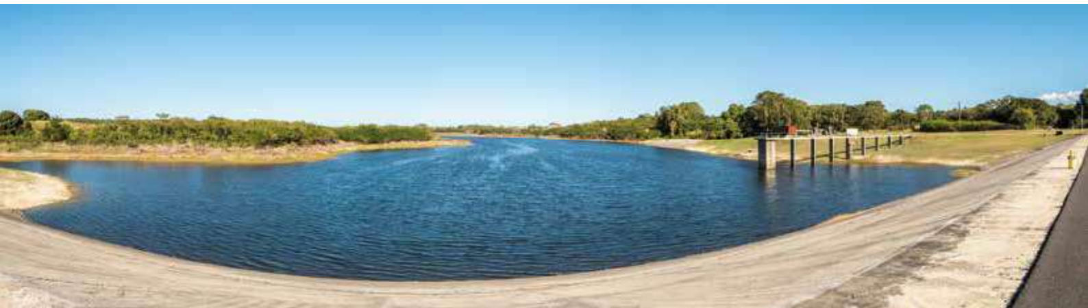
1990 Barrage de Gachet à Petit-Canal
