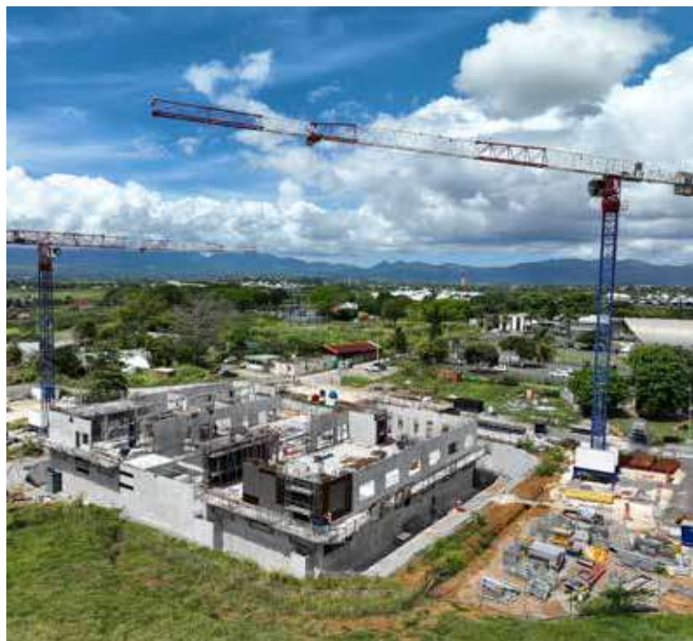
Chantier siège EDF
